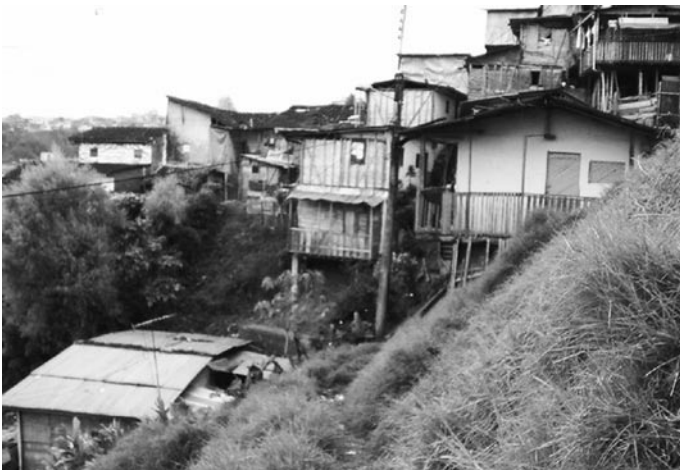
Figura 3. Ladera de alto riesgo con síntomas de inestabilidad.
